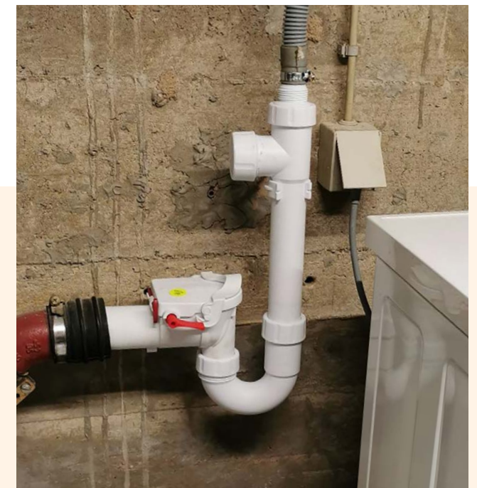
Rückstauklappen sorgen dafür, dass Kanalwasser nicht in das Haus zurückfließen kann, wenn sie regelmäßig gewartet werden.
