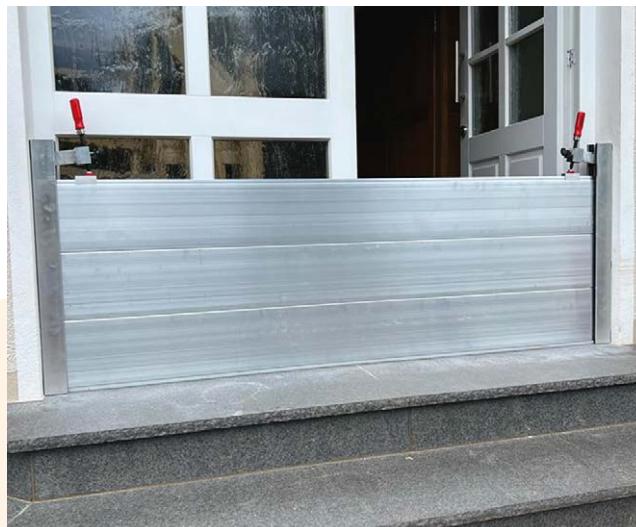
Dammbalkensysteme aus Aluminium werden mit Hilfe von Schienen im Türrahmen befestigt. Die Verschraubung von oben sorgt dafür, dass kein Wasser unter oder zwischen den einzelnen Balken durch laufen kann.
